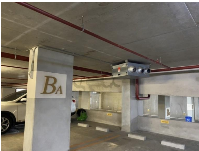
รูปที่ 11 พัฒนาดูดอากาศในอาคารจอดรถ A,B
