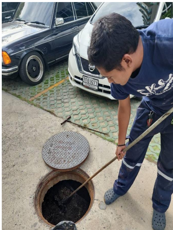
รูปที่ 13 ดำเนินการ ทำการตัดไขมันบ่อบำบัด อาคาร 1-3-5-8
